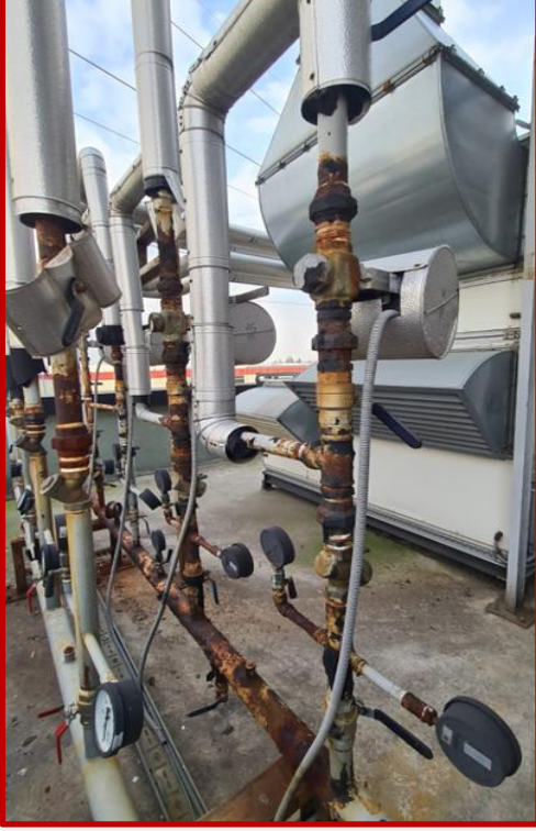
Isıtma Tesisat revizyonları!
